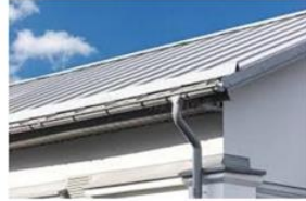
(屋頂雨水)屋頂雨水收集系統
