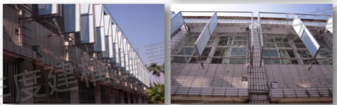
窗戶外架設沖孔遮陽板，阻絕陽光，亦有效達到通風散熱效果。
